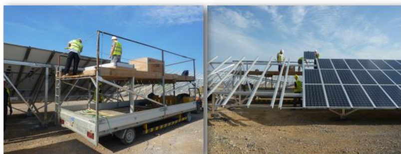
Pose des panneaux photovoltaïques
