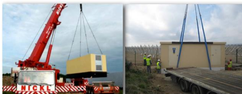
Pose d'un poste de livraison
