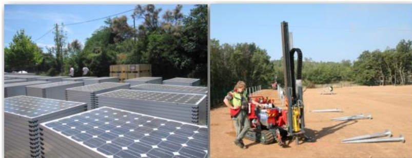
Zone de stockage des panneaux
